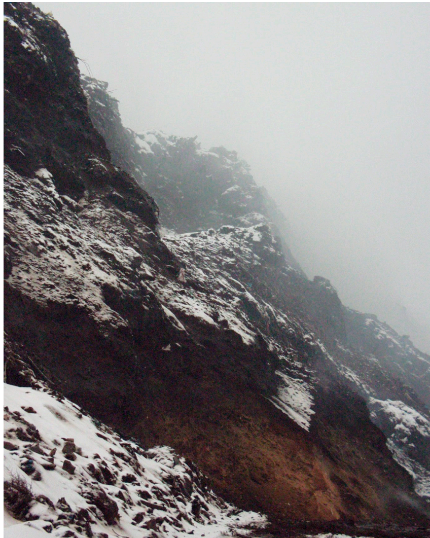
Рис. 19 Почти вертикальный уклон откосов свалки
