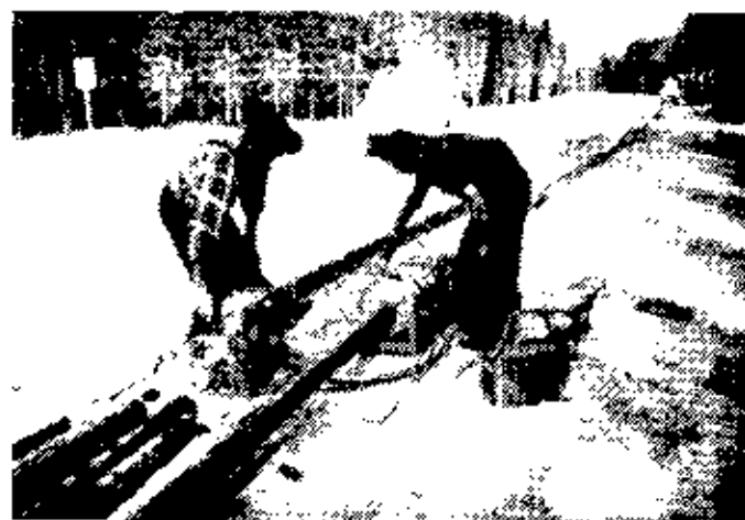
Рисунок 139. Сварка труб по стеновой схеме организации работ
