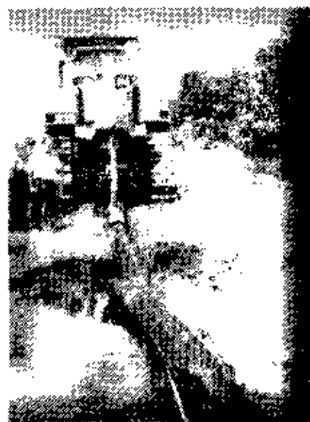
Рисунок 144. Полиэтиленовая труба втягивается в канал, образованный плужно-ножевым рабочим органом трактора
