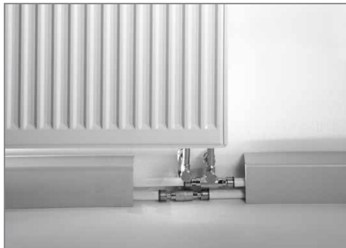
Подключение радиатора из плинтуса
