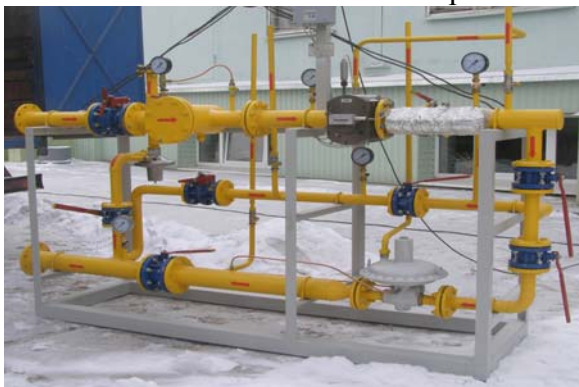
Рис 3.2. - Газорегуляторная установка
