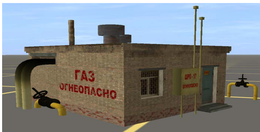
Рис 3.4 - Стационарный газорегуляторный пункт
